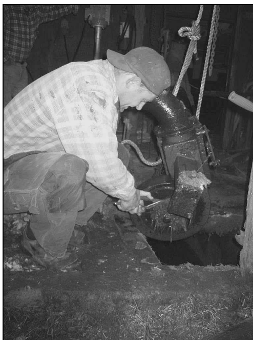
Figur 10. Erik reparerar gödselpumpen i pumprummet intill ladugården.
