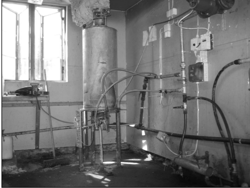
Figur 8. Rostfri värmepanna i pumprummet intill anläggningen.
