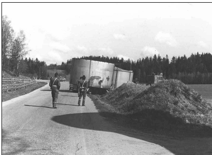
Figur 4. Tanken transporterades i två delar från Göteborg till Stommen där den åter svetsades ihop.
